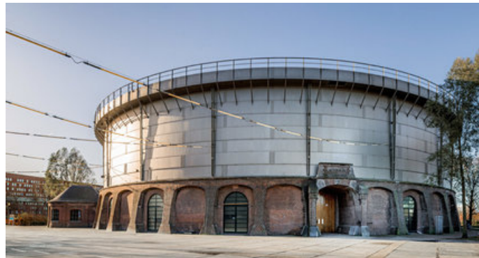
Gashouder, Westergas Amsterdam
